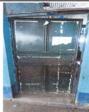
Foto 3: Remosamiento de puertas lijado y pintado y cambio de chapa.
