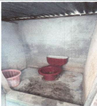
Foto 5: Instalación de azulejos para sanitarios.
