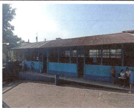
Foto 6: Instalación de lamina troquelada y estructura.
