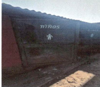
Foto 2: Remozamiento de puertas lijadas unidad y pintado.
