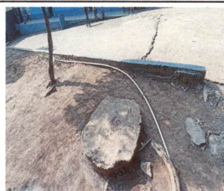
Foto 4: Sustitución de tubería pvc para sanitarios.
